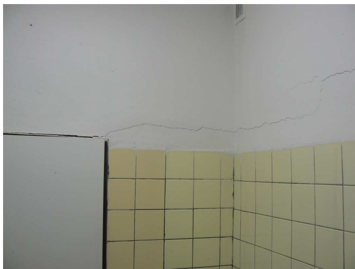
F2 Pohľad na trhliny v priečke a v stene v nároží predsene WC dievčat nad obkladom a nad dvermi
