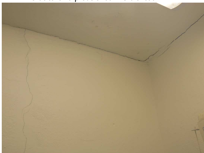
F11 Pohľad na zvislú a horizontálne trhliny v priečkach medzi WC učiteľiek a WC chlapcov
