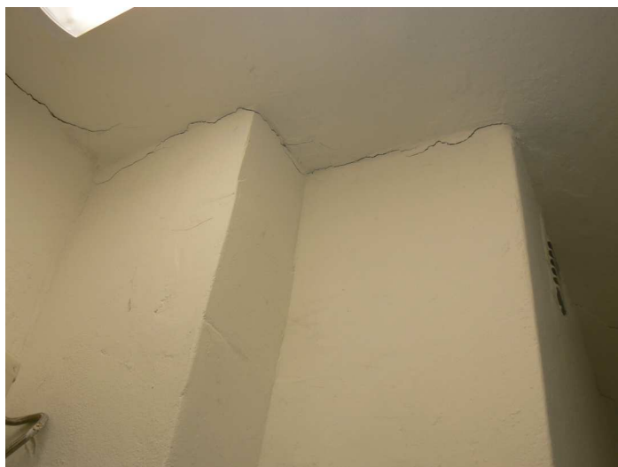
F13 Pohľad na horizontálne trhliny pod stropom v stene a priečke medzi WC učiteľiek a WC dievčat
