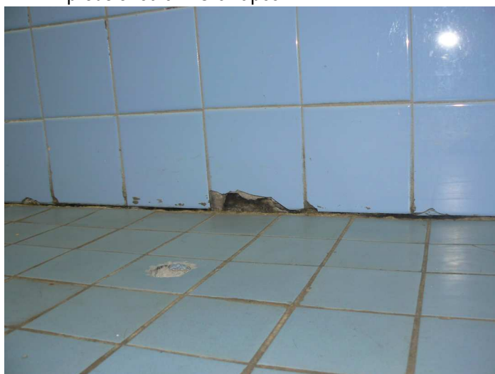
F24 Detail trhliny v styku podlahy predsie WC chlapcov s priečkou medzi ňou a miestnosťou upratovačky
