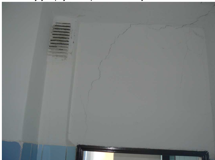
F22 Pohľad na trhliny nad dverami v priečke medzi predsieňou a WC chlapcov
