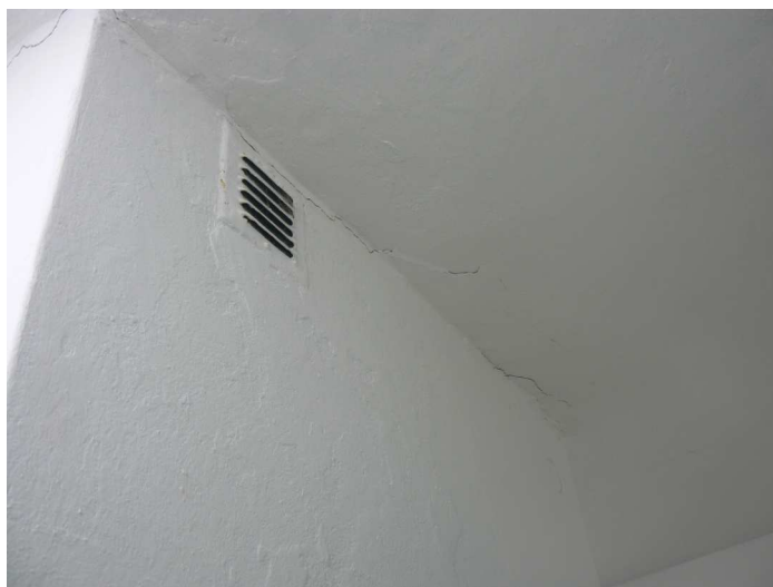
F14 Pohľad na horizontálnu trhlinu tesne pod stropom v priečke medzi WC učiteľiek a WC dievčat
