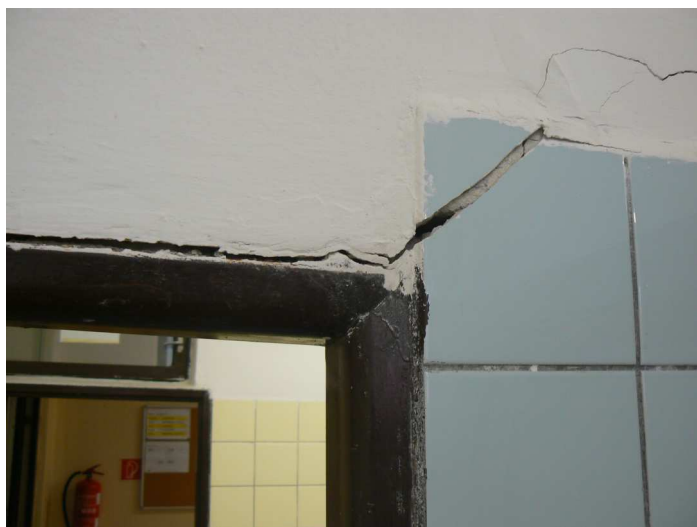
F7 Detailný pohľad na priebeh trhliny nad a pri dverách medzi WC dievčat a predsieňou
