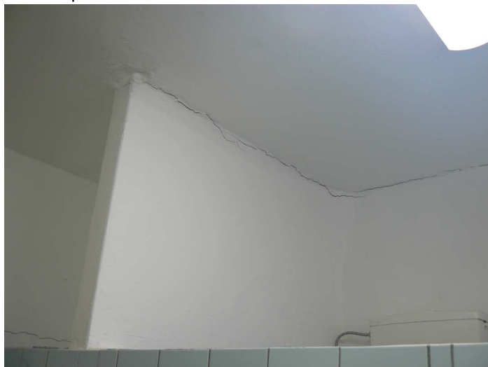
F15 Pohľad na horizontálne trhliny tesne pod stropom v stene a v priečke medzi WC dievčat a WC učiteľiek
