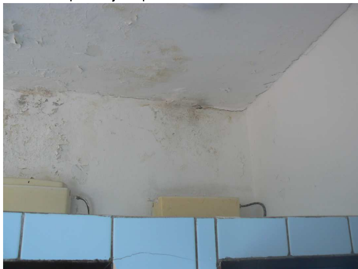
F27 Pohľad na trhlinu tesne pod stropom v stene medzi WC chlapcov a WC dievčat a jej výrazné zatečenie
