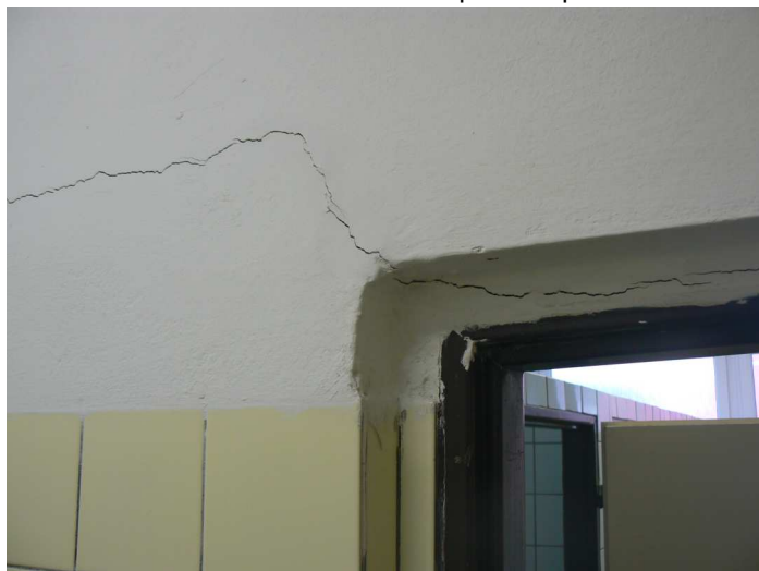
F3 Detailný pohľad na trhlinu v priečke pri a nad dverným otvorom medzi predsieňou a WC dievčat
