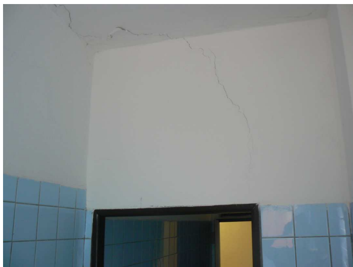
F25 Pohľad na trhliny v priečke nad dverami medzi WC chlapcov a jeho predsieňou
