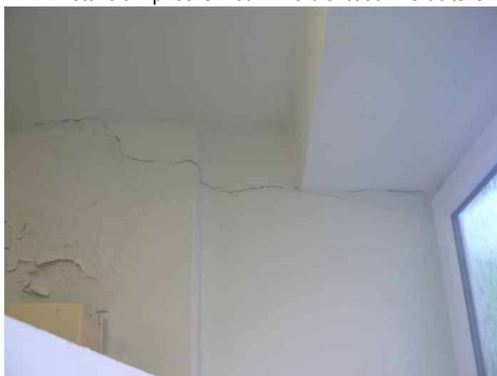
F17 Pohľad na trhlinu pod stropom a prievlakom v stene a v priečke medzi WC dievčat a WC chlapcov
