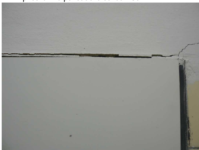
F6 Detail trhliny nad dverami v stene medzi predsieňou WC dievčat a miestnosťou upratovačky
