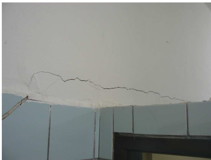
F8 Detailný pohľad na priebeh trhliny v nároží priečok WC dievčat pri predsieni
