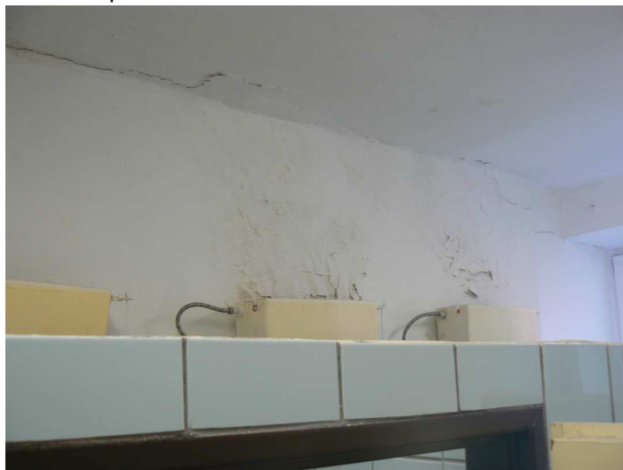
F16 Pohľad na trhlinu tesne pod stropom v stene medzi WC dievčat a WC chlapcov a jej výrazné zatečenie
