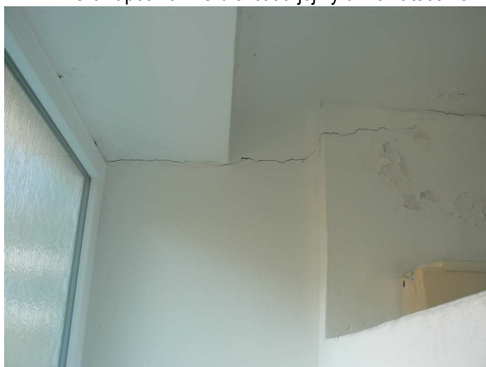
F29 Pohľad na trhlinu pod stropom a žb. prievlakom na okraji steny medzi WC chlapcov a WC dievčat
