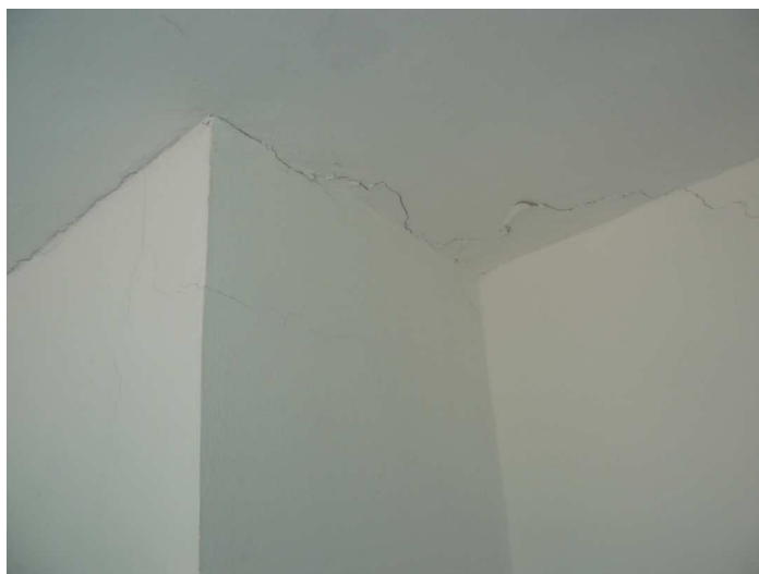
F26 Pohľad na trhliny tesne pod stropom v priečkach medzi WC chlapcov a WC učiteľiek
