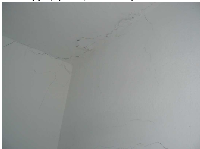
F21 Pohľad na trhliny pod stropom v priečkach v nároží medzi predsieňou, WC chlapcov a WC učiteľiek
