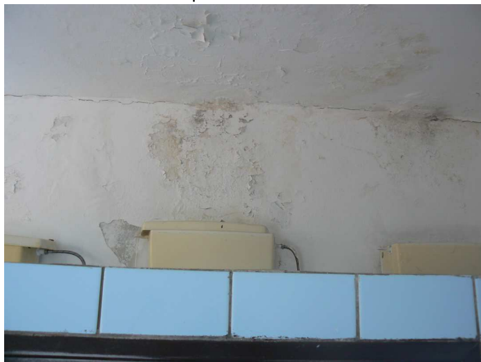
F28 Pohľad na trhlinu tesne pod stropom v stene medzi WC chlapcov a WC dievčat a jej výrazné zatečenie
