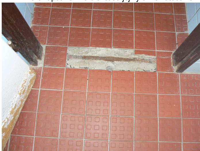
F30 Pohľad na vrt v podlahe WC chlapcov pre prieskumnú penetračnú sondu "PS2"
