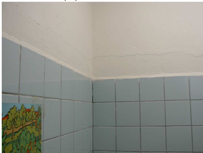
F10 Pohľad na trhliny v priečkach medzi WC učiteľiek, miestnosťou upratovačky a predsieňou WC chlapcov
